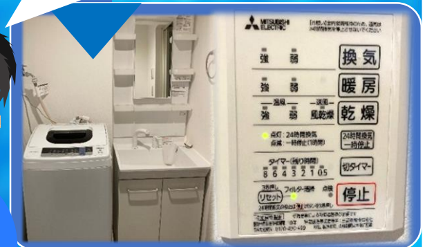
洗濯機 浴室乾燥機
